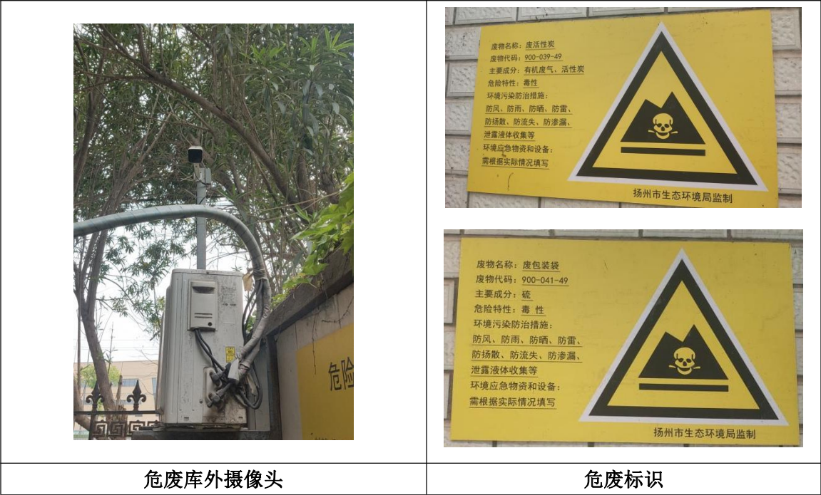
图4.1-3 企业危险废物设施现场管理情况
